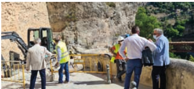
Visita a las obras
